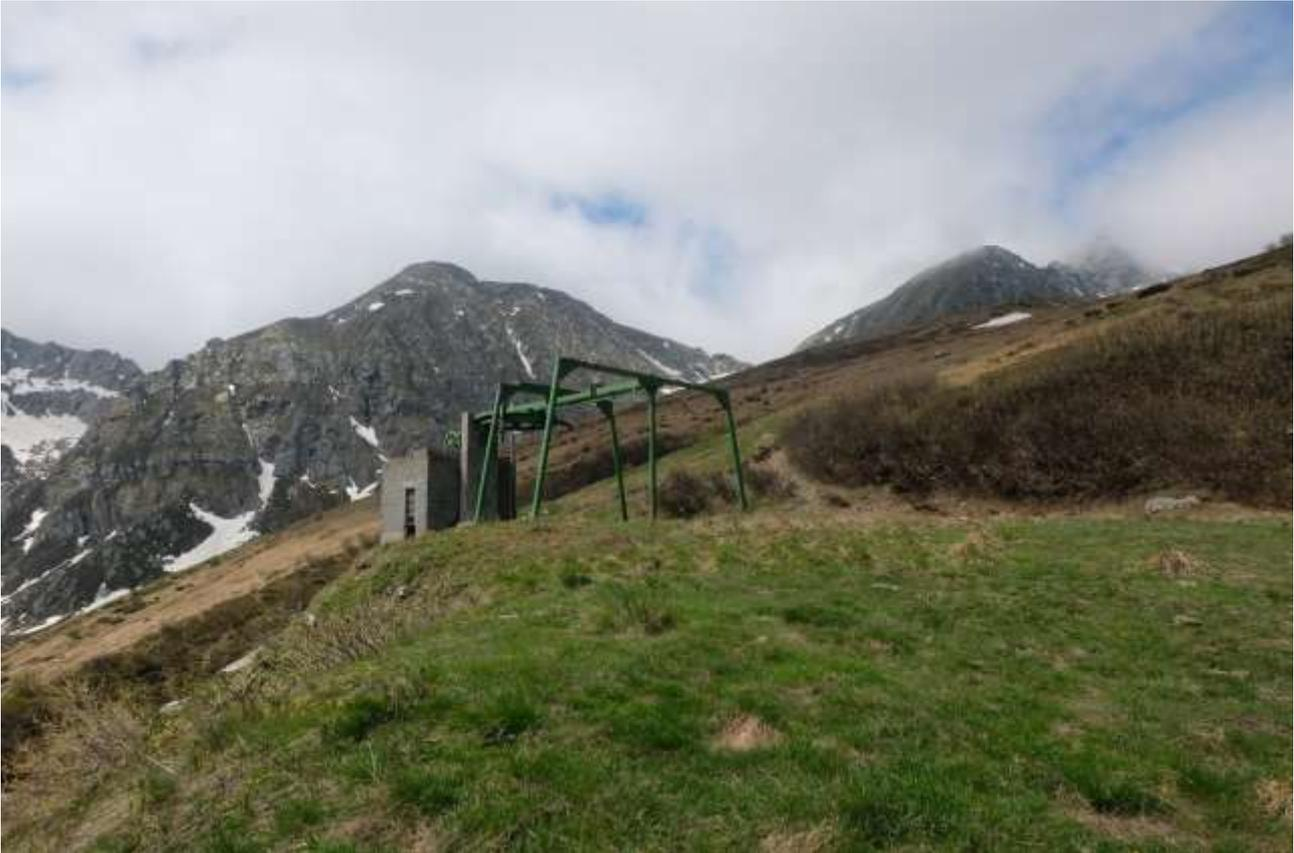
*Figura 29 Stazione di arrivo della vecchia sciovia che verrà demolita.*
